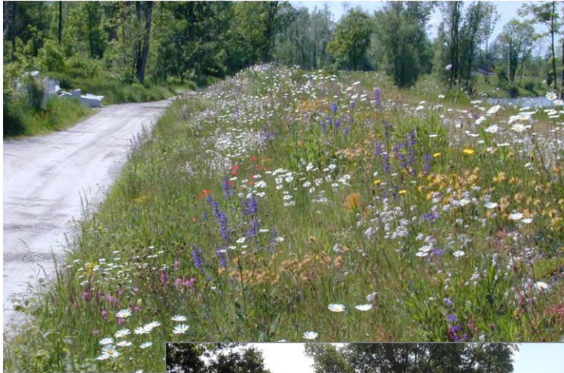
Magerrasen auf landseitiger Böschung auf oligotrophem, grobkörnig-kiesigem Substrat – Mangfall bei Kolbermoor (Quelle: WWA Rosenheim, Bayern; aus DWA-M 507 Teil 2)
