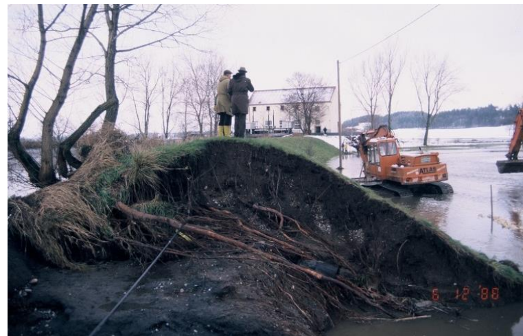
Deichbruch bei Höselhurst an der Donau HW 1988 (Quelle: TU München)
