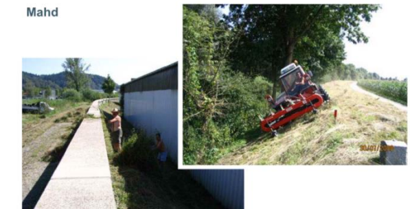
manuelle Mäh, Deggendorf-Staatshefen (Donau), WWA Deggendorf 2009 maschinelle Mäh bei steiler Böschung und Gehölzbestand, Anning (Donau), WWA Deggendorf 2008
