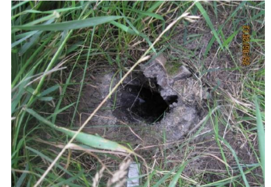
Wurzel mit Hohraum nach Gehölzfreistellung auf einem Deich in Ostdeutschland Quelle: R. Haselsteiner
