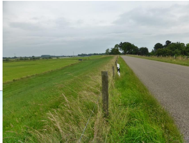
Magerrasen auf landseitiger Böschung auf oligotrophem, grobkörnig-kiesigem Substrat – Mangfall bei Kolbermoor (Quelle: WWA Rosenheim, Bayern; aus DWA-M 507 Teil 2)
