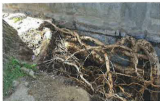
Abbildung 6: Ausgegrabene Wurzeln einer Pappel an einer HWS-Mauer im städtischen Bereich von Düsseldorf
