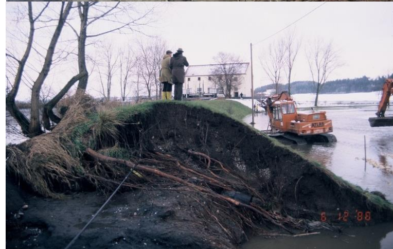
Deichbruch bei Höselhurst an der Donau HWS1988 (Quelle: TUM)
