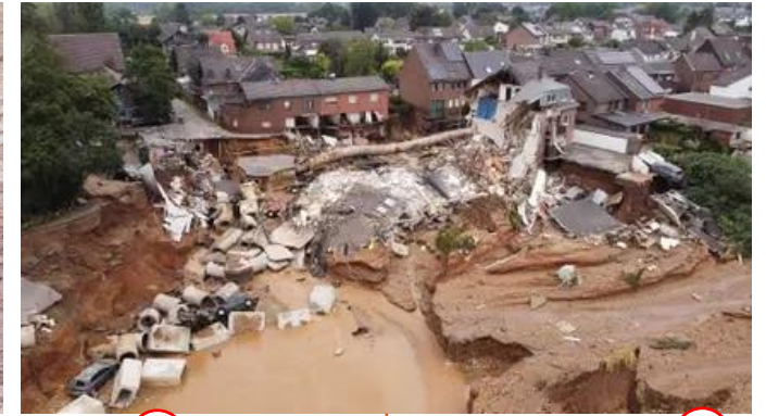
Flood 2021 on the River Erft, City Erftstadt Blessem, Source: www.rnd.de
