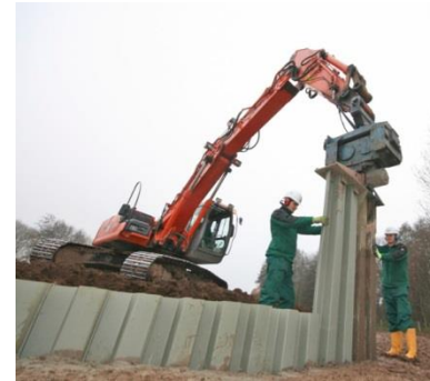
Kunststoffspundwand (Firma g 2 )
