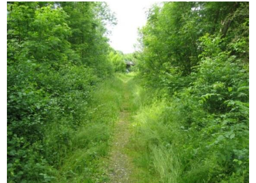
Deich an der Iller bei Altenstadt (Quelle: TUM)
