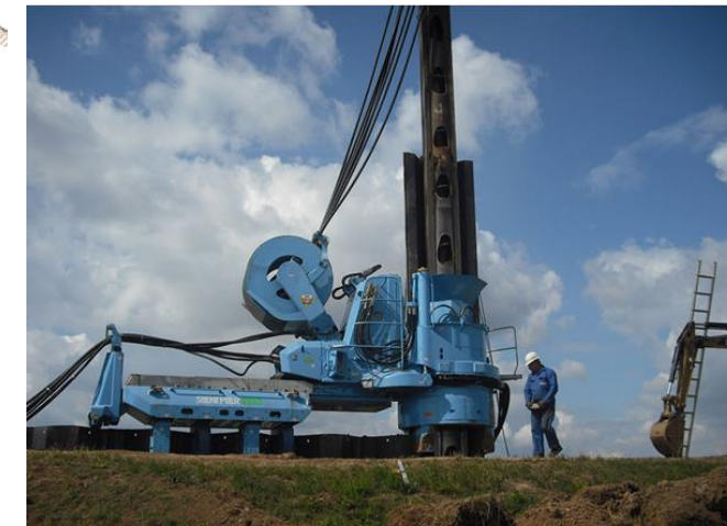
Silent Piler (Hermann Koth Ingenieurbau)
