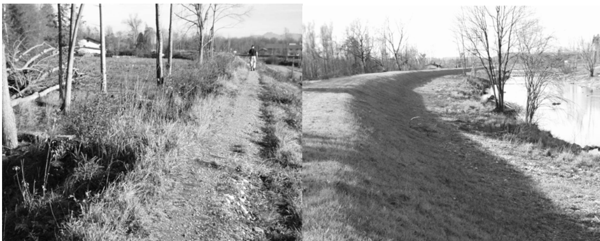
Abb. 3-19: Deiche bei Götting (Landkreis Rosenheim) mit variierendem Bewuchs auf der wasserseitigen Böschung und Gehölzbeständen auf der Landseite (links: Abschnitt vor Sanierung / rechts: Abschnitt nach Sanierung 1985)
