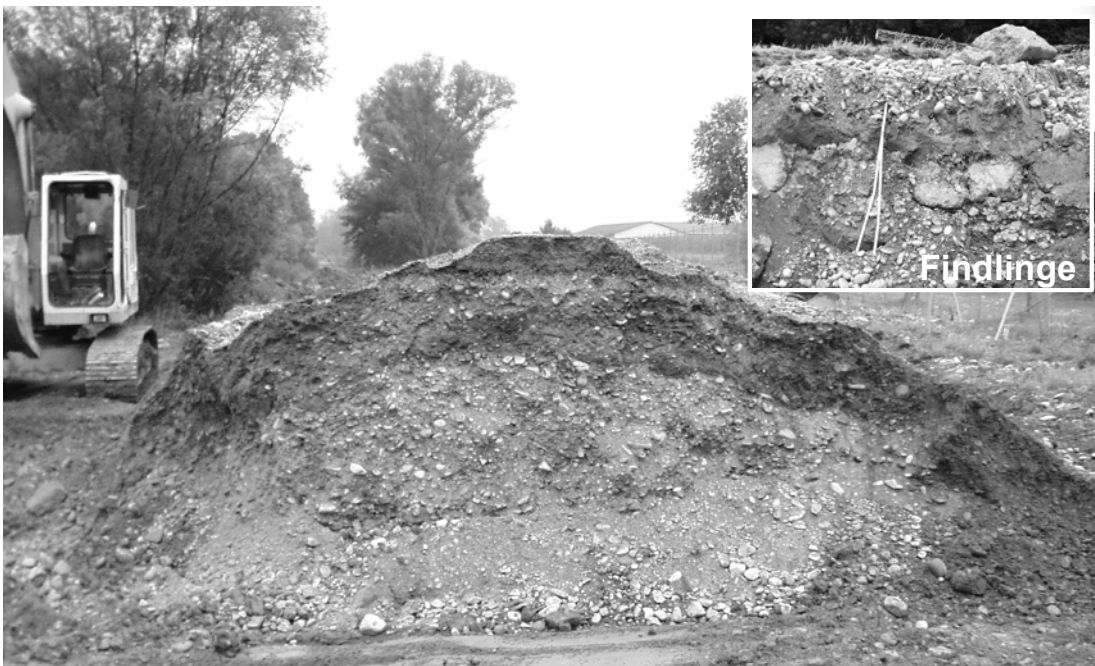
Abb. 3-8: Aufgegrabener Deich an der Mangfall (Quelle: WWA Rosenheim)
