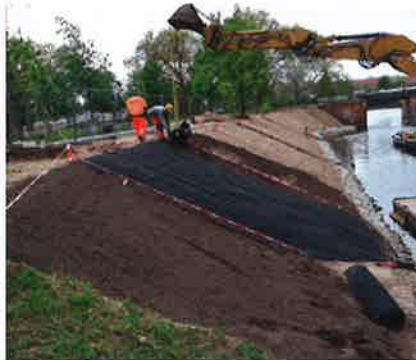
Erosion/Wühltierschutz an Kanalböschung
