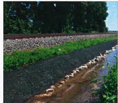
Erosion/Wühltierschutz an einer Eisenbahnstrecke
