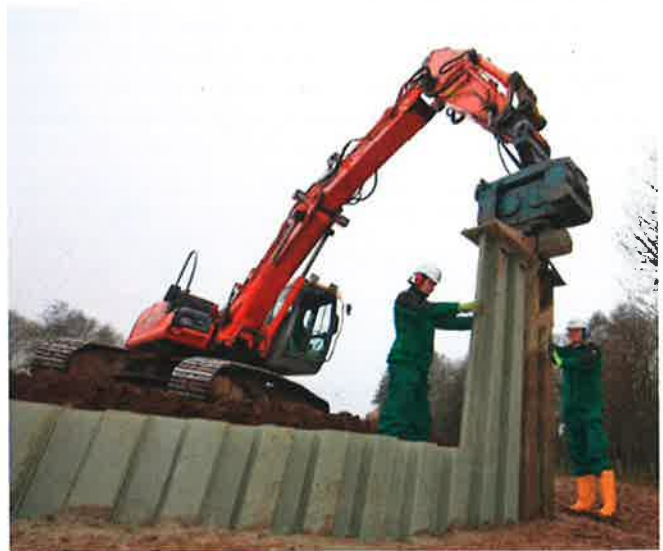
Abb. 1: Einbau einer Kunststoffspundwand (Quelle: Firma G quadrat GmbH) [35]
