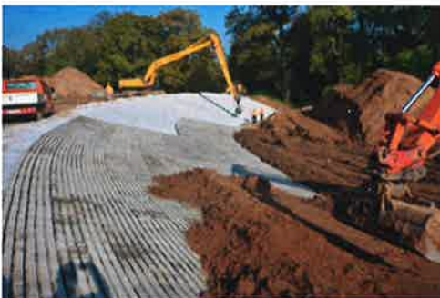
Deich bei Lödderitz (Saale/Elbe, Wühlerschutz)
