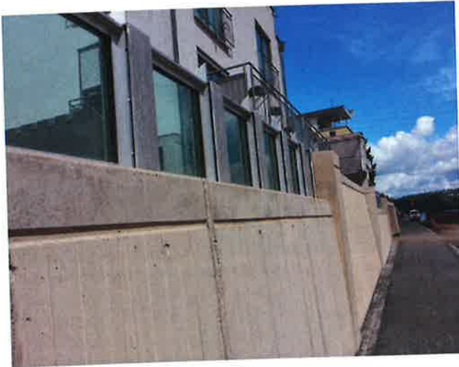
Abb. 4: Hochwasserschutzmauer mit aufgesetzten Glaselementen in Koblenz am Rhein
