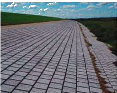
Deich auf der Luneplate (Weser, Erosionsschutz)
