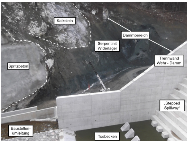
Bild 13: Baustellenzustand 12/2013 (vom orographisch rechten Ufer aus gesehen)
