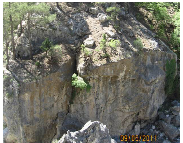
Bild 8: Kalksteinblöcke im Bereich von Schnitt C-C (Bild 1) weit unterhalb der Bauwerksachse am rechten Ufer
