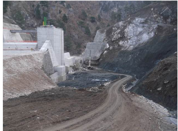
Bild 14: Baustellenzustand 12/2013 (von Oberwasser mit Blick Richtung Unterwasser)
