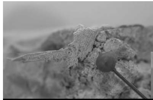
Abb. 5-3: Holzpartikel im Betongefüge in Bohrkern aus Finsing
