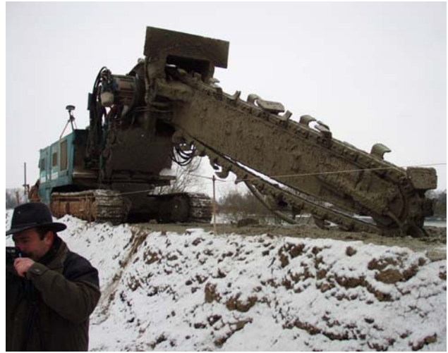
Abb. 12: Grabenfräse im Einsatz auf einem Donaudeich bei Niederaltaich (Quelle: TUM)
