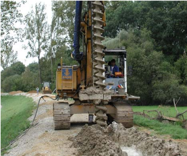
Abb. 11: MIP-Gerät im Einsatz an einem Deich an der „Kleinen Donau“ (Quelle: WWA Ingolstadt, Bayern)
