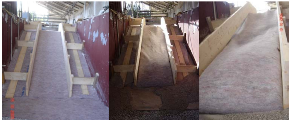
Abbildung 4.2-2 Versuch 01 vor Überströmung (links), nach Überströmung (mittig) und Sandbeule am Deichfuß nach Überströmung (rechts)
