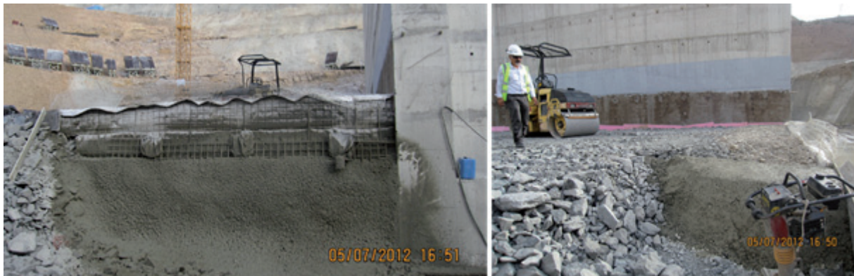
Abbildung 16: Arbeiten an Wand KKD1 – Spritzbetonoberfläche (links) – Zonierung und kleine Verdichtungsgeräte (rechts)
