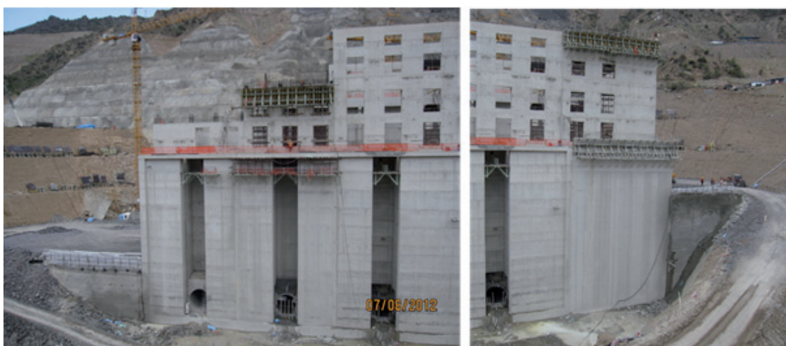
Abbildung 12: Baufortschritt zum 07.08.2012 – 25 % von KKD1 und 50 % von KKD2
