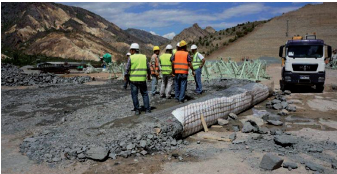
Abbildung 10: Eingebaute erste Lage des Versuchsfeldes mit der vertikalen Stirnfläche (16.05.2012) (Foto: IBH)
