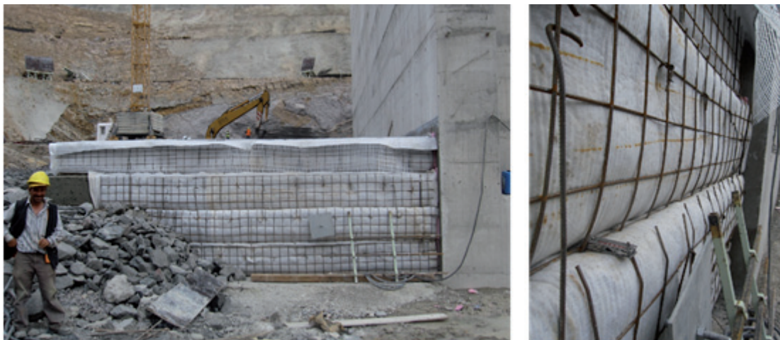
Abbildung 15: Arbeiten an Wand KKD1 – Lagenweiser Einbau mit „totem Mann“ (links) – Vertikale Stirnfläche mit Drainageelement Secudrain 201 WD601 201 und Stahlmatten (rechts)
