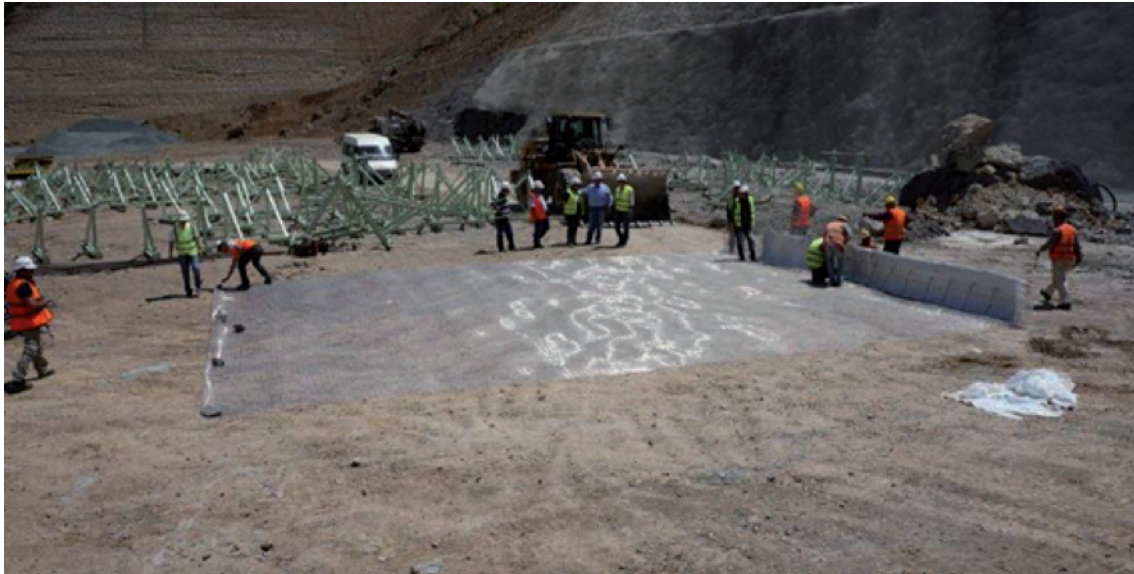
Abbildung 9: Vorbereiten des Versuchsfeldes mit der Basisbewehrungslage Secugrid 200/40 R6 und der vertikalen Stirnfläche (16.05.2012) (Foto: IBH)
