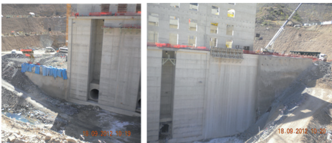
Abbildung 13: Baufortschritt zum 18.09.2012 – 25 % von KKD1 und 100 % von KKD2
