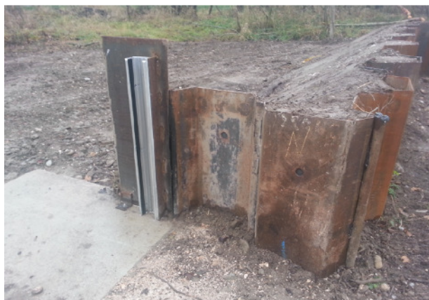
Unverkleidete Spundwand mit mobilem Verschluss im Rahmen einer Sofortsicherungsmaßnahme an der Saalach
