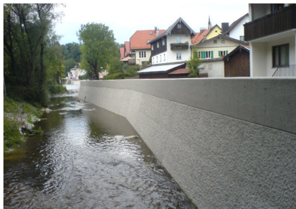
HWS-Mauer mit unterschiedlich gestalteten Betonoberflächen an der Isar
