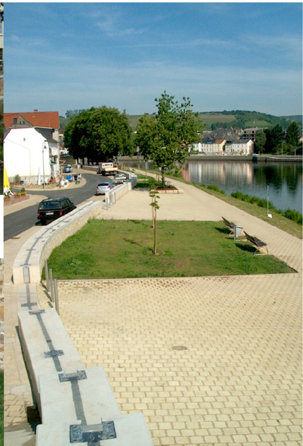
Geschwungene HWS-Mauer mit aufgesetzten Dammbalken an der Mosel
