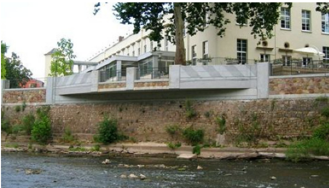
Verkleidete HWS-Mauer mit Balkon an einem Zufluss vom Rhein
