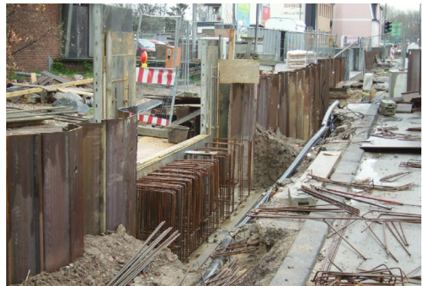
Verkleidete HWS-Wand ausgeführt mit mobilem Verschluss entlang Verbauung und Straße am Niederrhein
