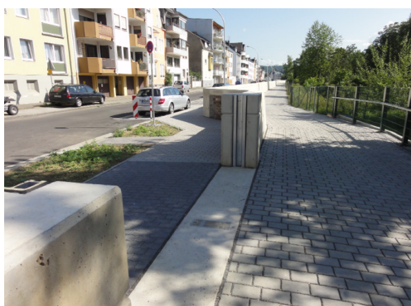
Einfache HWS-Wand ohne Verkleidung mit integrierten Dammbalkenverschlüssen
