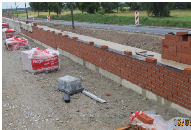
Verklinkerte HWS-Wand ausgeführt als wasserseitige Spundwand am Niederrhein
