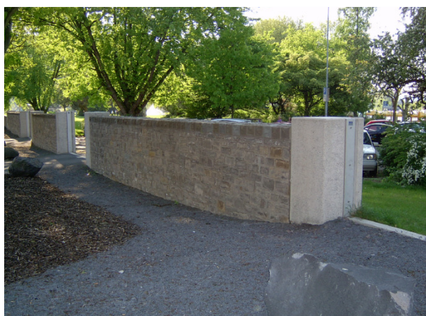
HWS-Mauer in Kombination mit mobilen Verschlüssen (Dammbalken) am Mittelrhein
