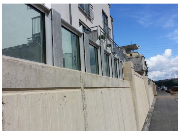
HWS-Wand mit aufgesetzten schuss- und stoßsicheren Glaselementen am Mittelrhein
