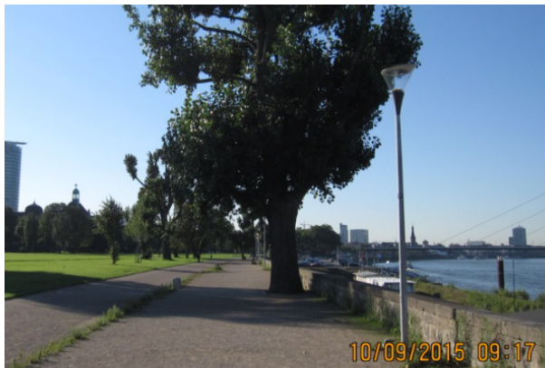
Große Einzelbäume an einer HWS-Mauer in einer Großstadt am Rhein
