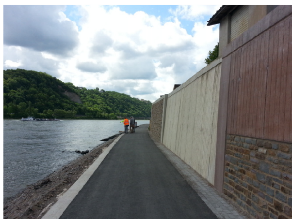
Unterschiedlich gestaltete HWS-Mauern mit Sichtbeton, Naturstein und gefärbten Beton am Mittelrhein
