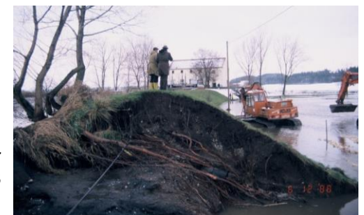
Deichbruch bei Höselhurst an der Donau während Hochwasser 1988 (Quelle: TUM)
