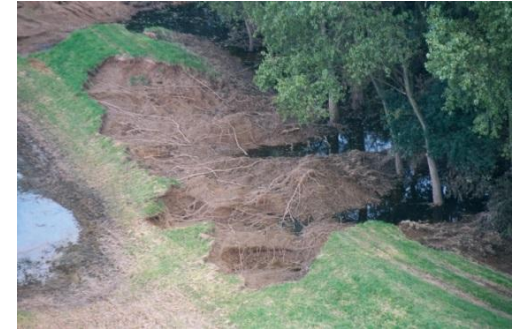
Deichbruch an der Mulde während des Hochwassers 2002 (Quelle: LTV Sachsen)
