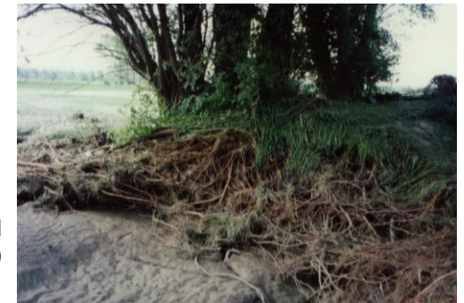
Deichbruch an der Ammer während Pfingsthochwasser 1999 (Quelle: WWA Weilheim)
