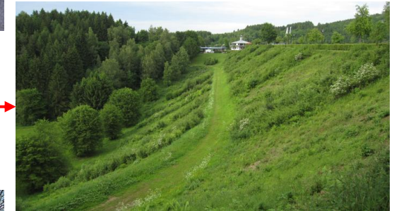
Landseitige Böschung der Biggetalsperre, Ruhrverband (Quelle: Dr. Haselsteiner)
